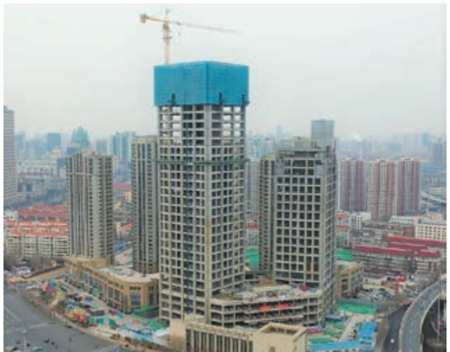
寫字樓大樓及商業平台 — 上蓋建築工程現正進行中
