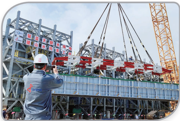
本集團承接的浙江石化2# 乙烯裝置項目獲評為文明施工樣板工地稱號
