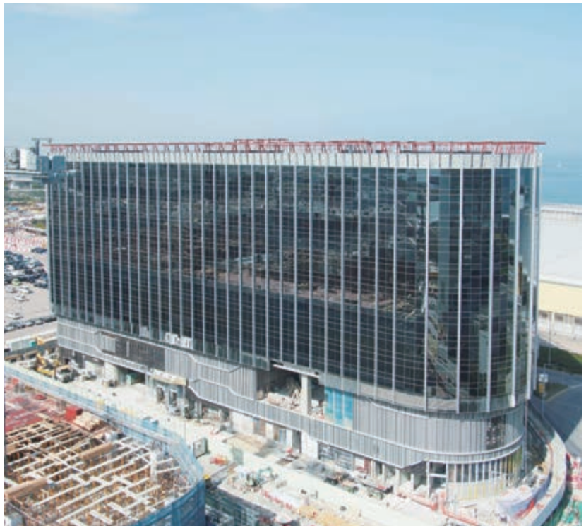
麗豪航天城酒店 — 上蓋建築工程已完工
