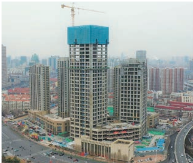
寫字樓大樓及商業平台 — 上蓋建築工程進行中
