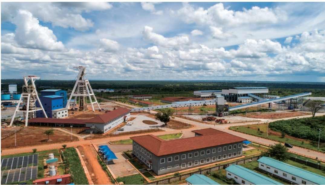
中色非洲礦業東南礦體生產控制中心
