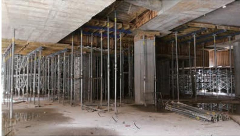
模板系統為一個用於構成臨時模具的系統，使混凝土得以灌入或置於其中，以建造永久構築物。於最後實際可行日期，我們擁有一套模板系統。
