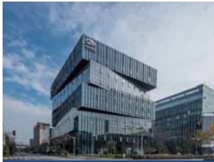
上海恒基旭輝中心 Shanghai Henderson CIFI Center
