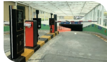
車牌識別停車道閘
