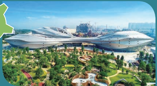
太陽能光伏一體化建築
