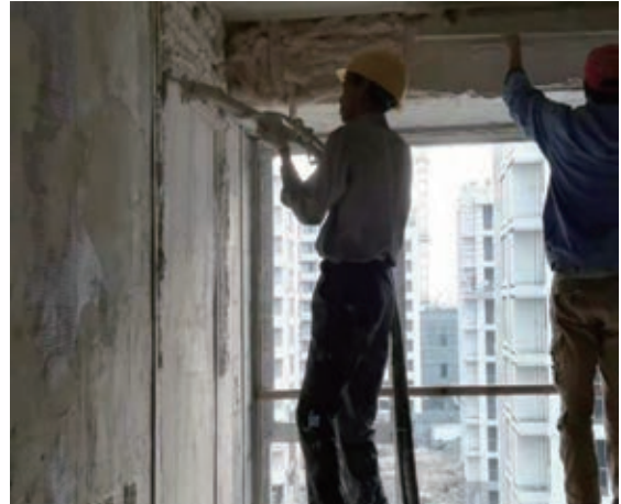
杭州天空之城項目粉刷石膏噴塗，機械噴塗粉刷石膏 可降低空鼓開裂可能、提升保溫性能
