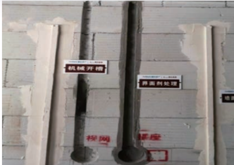
杭州天空之翼項目專用開槽機開槽後效果
