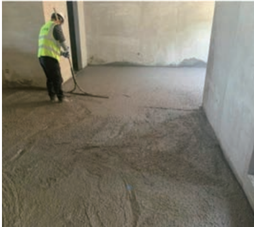
杭州印江南項目泡粒保溫樓地面， 提升保溫效果與工程質量
