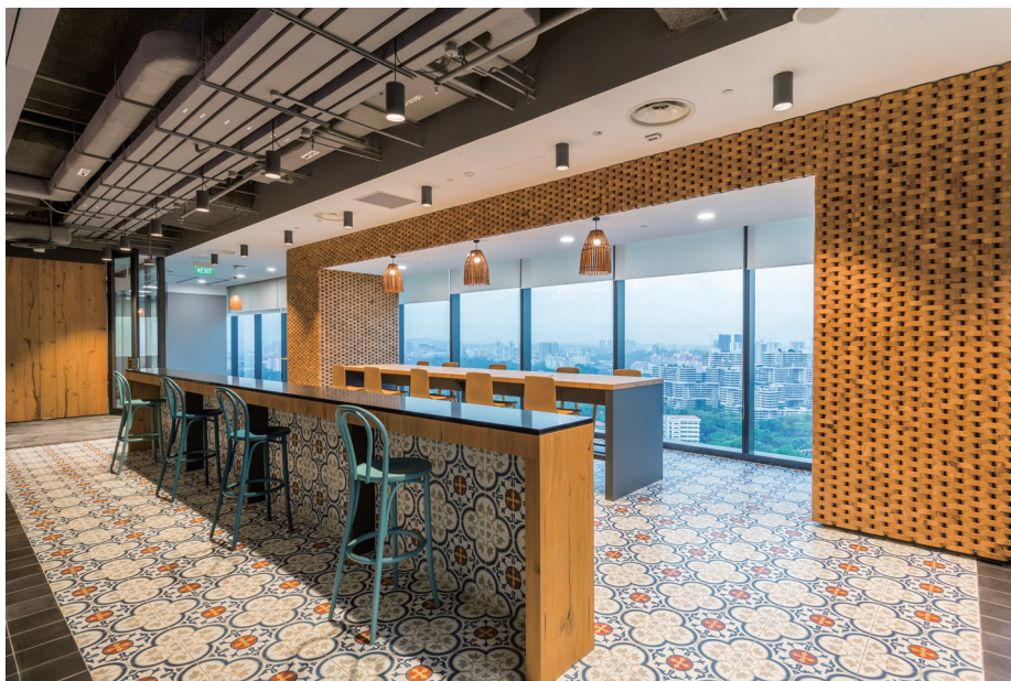
多節橡木飾面，黑色花崗岩檯面及激光切割橡木塊特色牆面的吧檯
