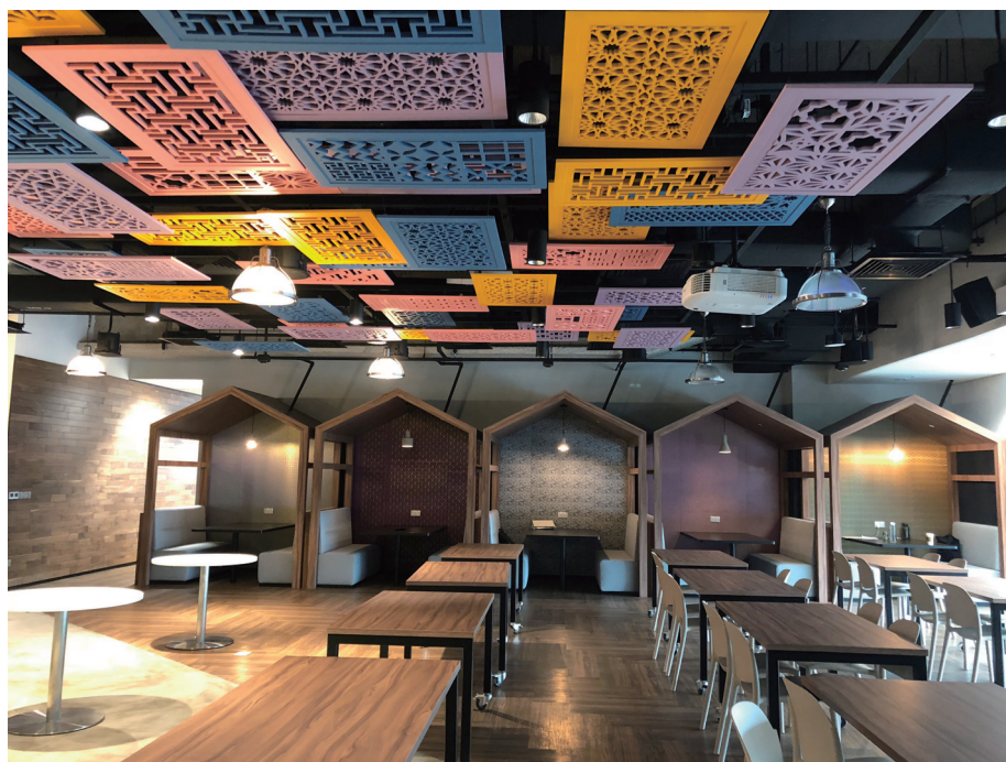
激光切割的特色中密度纖維板吊頂、橡木木材噴漆飾面及分隔板以及定製沙發組合
