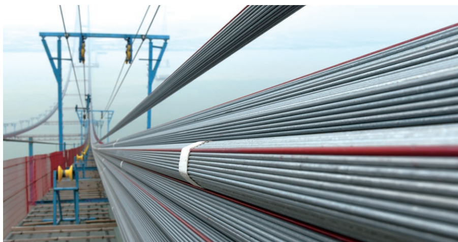
纜索安裝的施工現場
