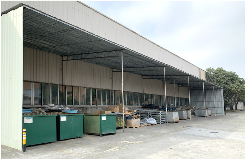
廠房外已設置生產廢料存放區
