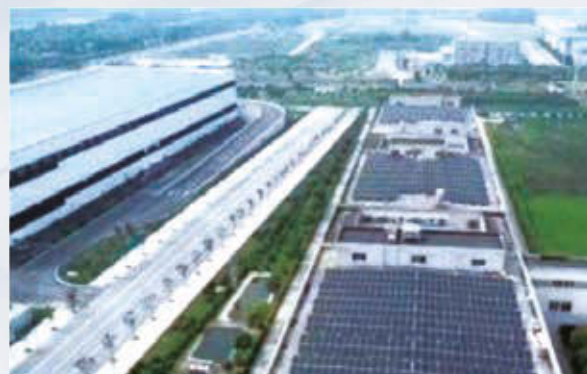
重慶廠區廠房房頂
