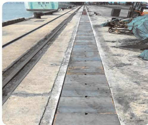
石湖山碼頭和海宇碼頭完成了碼頭前沿所有沉箱縫封堵以及電纜井和護輪坎圍堰，保證碼頭地面廢水不外溢，同步提升改造碼頭前沿排水溝，將截留的廢水收集並處理，處理後的中水回用於噴淋除塵、清洗車輛等。該措施避免碼頭前沿污水流入大海，改善海洋生態環境。
