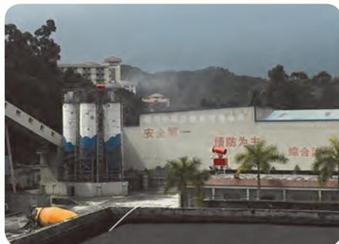
噴淋系統擁有220個噴淋噴嘴，覆蓋所有進出場道路，確保車輛不帶泥上路。
