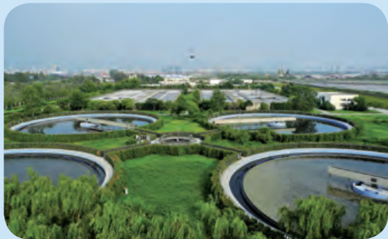
Lianyungang Dapu Waste Water Treatment Project 連雲港大浦污水處理項目
