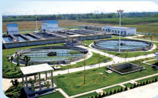
Zhangqiu Waste Water Treatment Project 章丘污水處理項目
