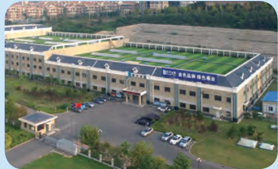
Dalian Siergou Waste Water Treatment Project 大連寺兒溝污水處理項目
