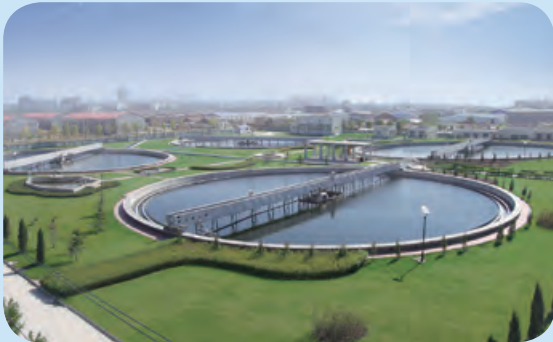
Ji'nan Waste Water Treatment Project 濟南污水處理項目
