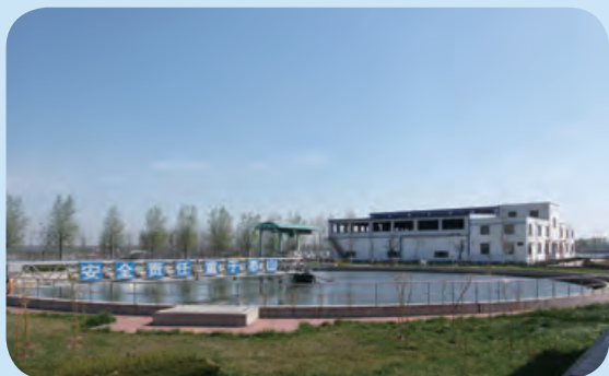
Dezhou Nanyunhe Waste Water Treatment Project 德州南運河污水處理項目
