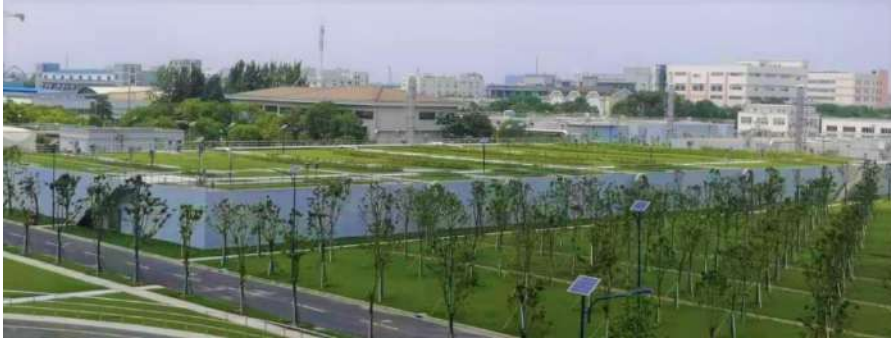
圖 3：青浦第二污水處理廠項目擴建四期生物池封蓋上種植綠色植物來淨化空氣，降低臭氣對周圍環境的影響。
