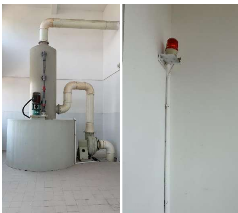
圖 7：華中分部一家水處理廠的氯氣吸收裝置（左圖）和報警系統（右圖）。
