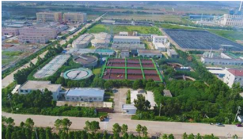
圖 4：臨海園區污水處理廠綠化程度高，種植用以淨化空氣的植物。
