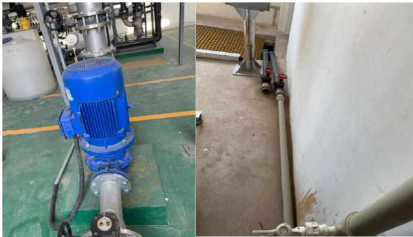
圖 24：華南分部的一家污水處理廠為實現尾水回用進行的管道改造。
