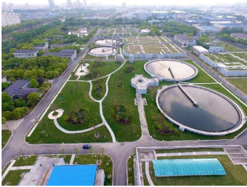
圖 1：上海青浦第二污水處理廠。
