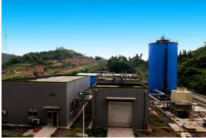
圖 14：達州市城市生活垃圾焚燒發電項目一階段的廢水處理系統。
