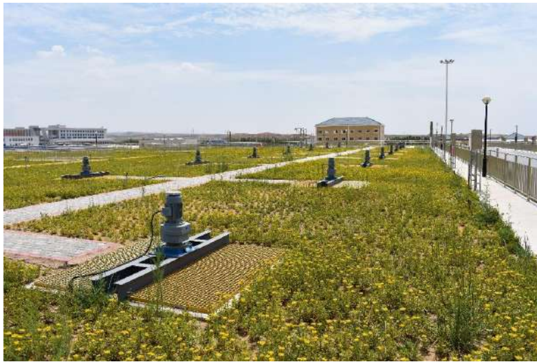
圖 2：銀川濱河新區污水處理廠一期項目對生物池進行加蓋。
