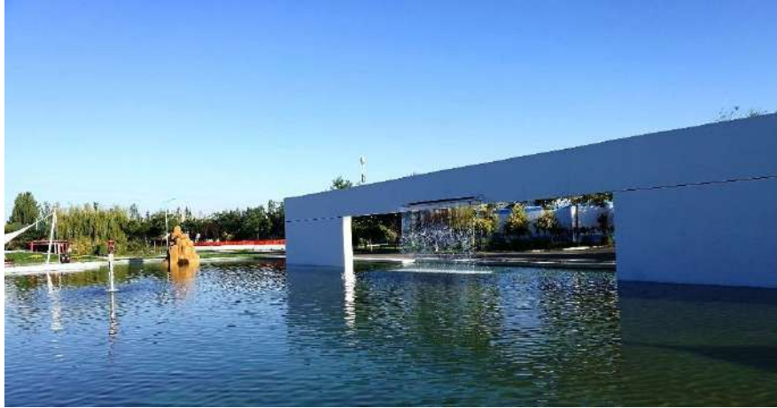
圖 23：銀川市第五污水處理廠景觀造型使用廠區循環水。
