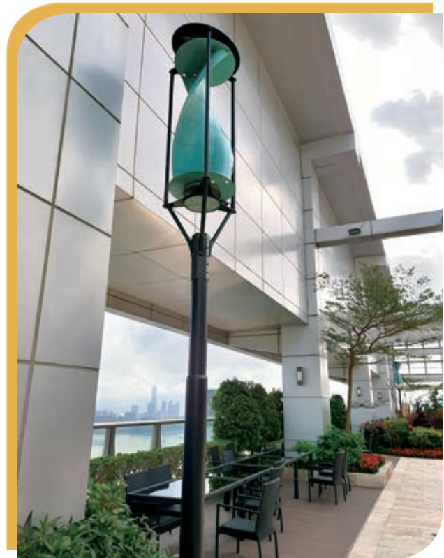
2019年，東亞銀行於東亞銀行中心安裝了風力發電的戶外照明系統。
