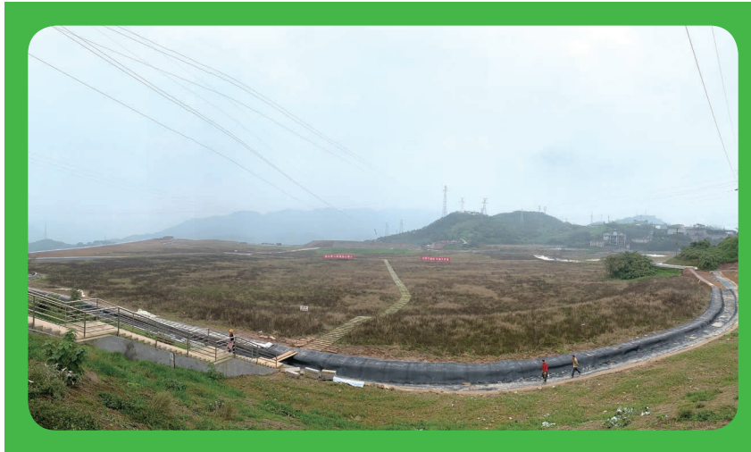
中化涪陵已閉庫及已覆土的磷石膏堆場
