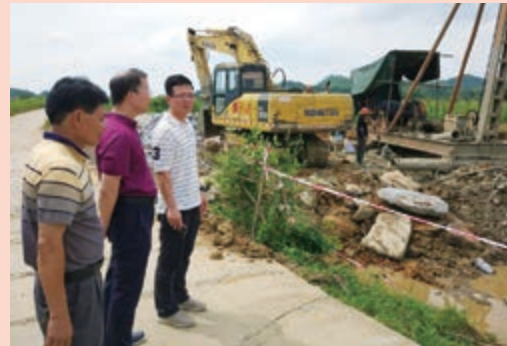
查看赤米橋施工進展
