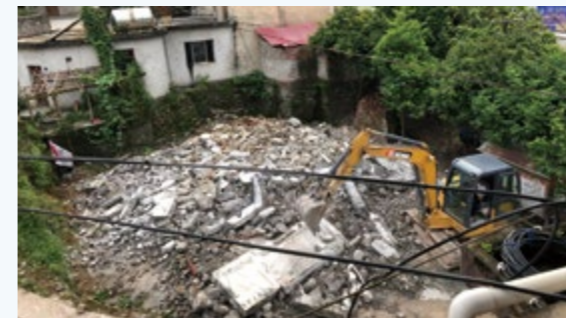
修建中的江口村卫生室
