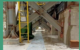
廢鐵板覆蓋消防水幕溝
