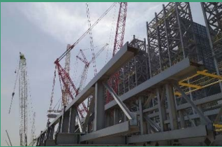
鋼結構工廠深化預製
