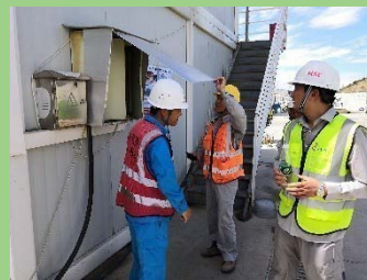
施工單位營地檢查(二)
