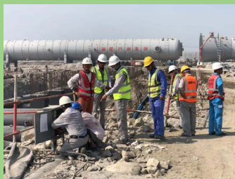
施工單位營地檢查(一)
