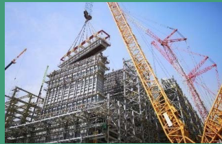
裂解爐模塊化安裝
