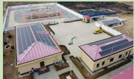
場站屋頂及停車空地處安裝光伏板
