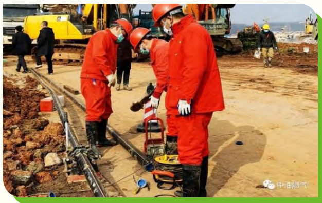
火神山醫院管線遷改工程
