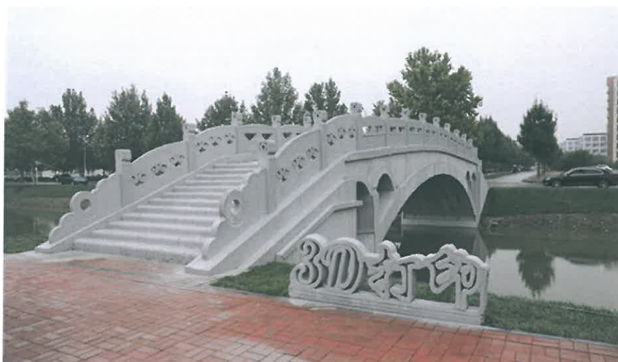
全球第一座裝配式 3D 打印仿趙州橋結構樣式橋梁
