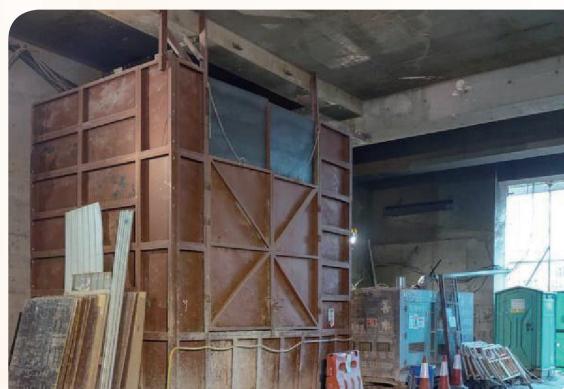
於建築地盤的建築廢棄物棄置區
