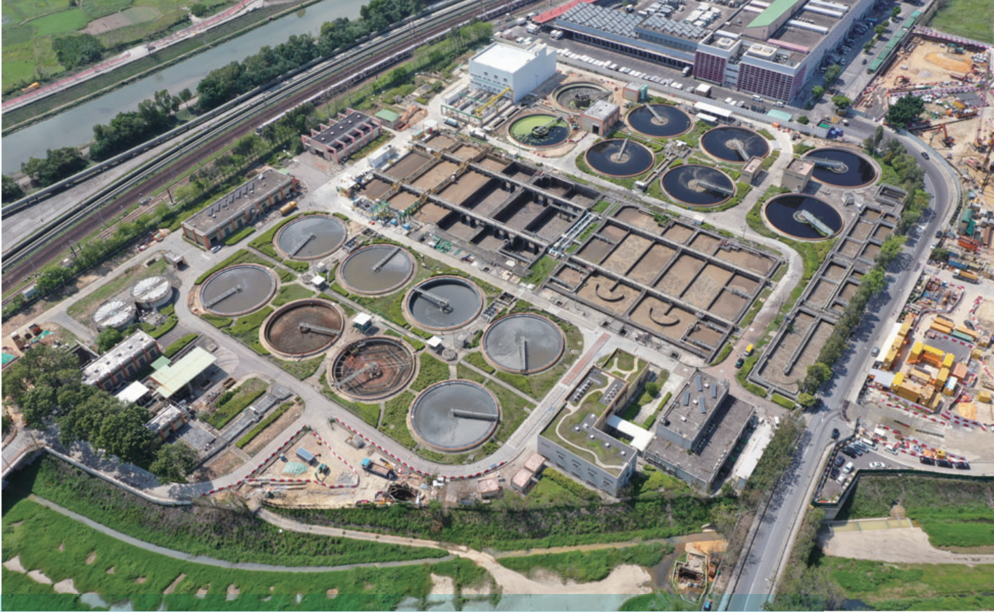
Shek Wu Hui Effluent Polishing Plant — Main Works Stage 1 — Civil Works for Sewage Treatment Facilities 石湖墟淨水設施 — 主體工程第一階段 — 污水處理設施的土木工程
