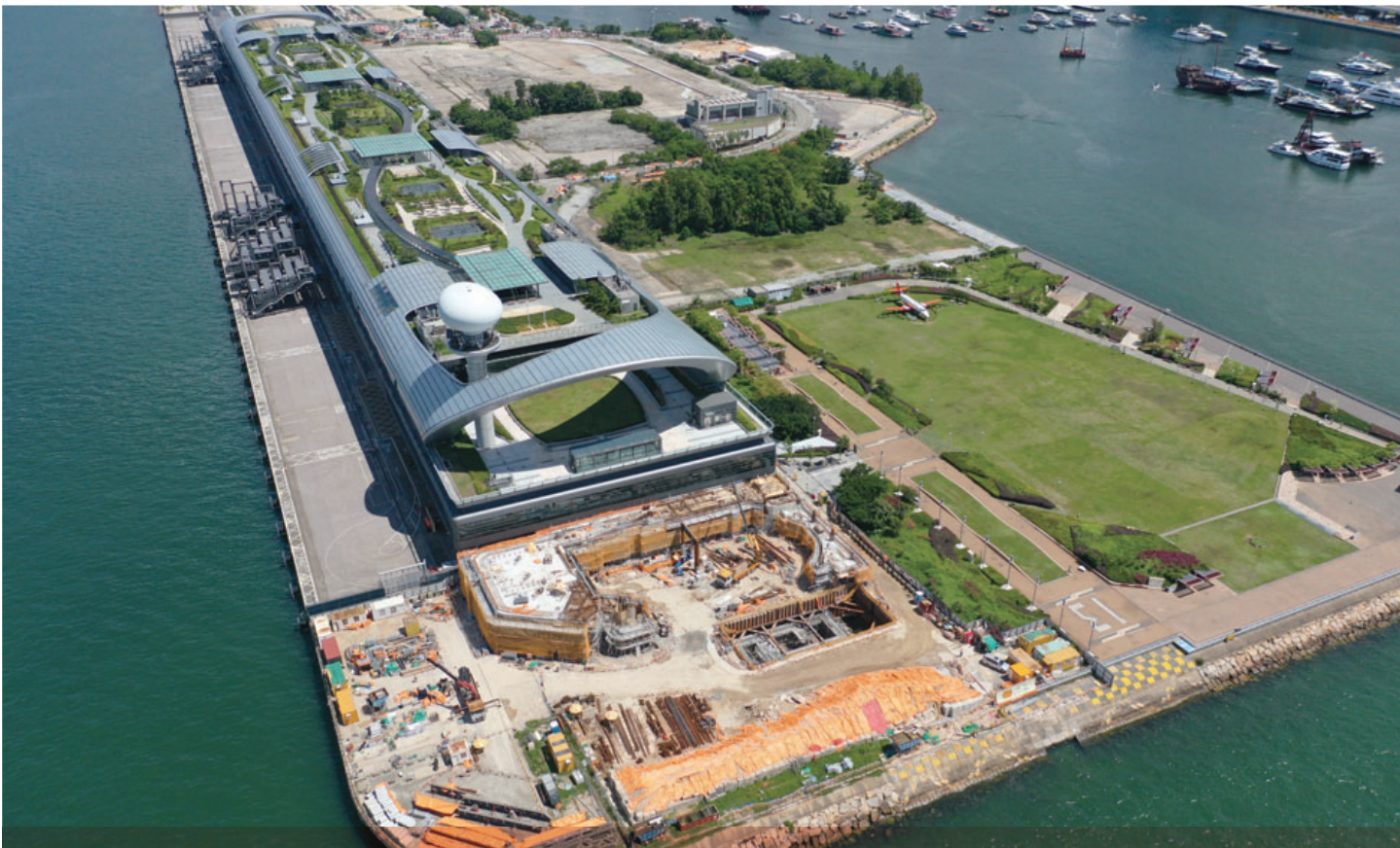
Construction of Government Flying Service Kai Tak Division 政府飛行服務隊啟德分部建造工程
