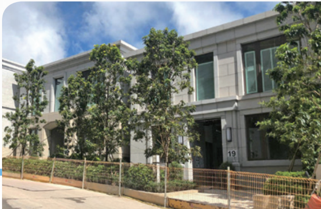
House development at No. 1 Plantation Road, Hong Kong 香港種植道第1號洋房發展項目
