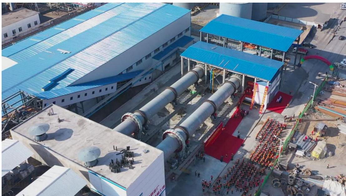
巴彥淖爾紫金鐵閃鋅礦濕法冶煉浸出渣資源綜合利用及無害化處理技術工程項目於 9 月 29 日轉入生產階段，該項目達產後，將實現對冶煉尾渣中的有價金屬全部回收，由危險廢物轉為一般固廢，可以用於建築原料，實現廢物資源化利用。
