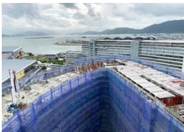
一般樓層建築使用鋁材模板，以減少使用木材。
