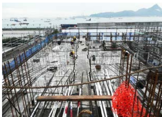
一般樓層建築使用鋁材模板，以減少使用木材。
