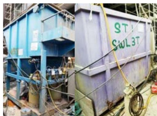
建築地盤的污水處理設施
