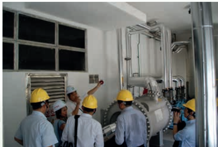
中國廣東省電力供需調節適用能源管理系統實證項目節能技術交流會 專家組參觀回收熱污水餘熱項目現場
