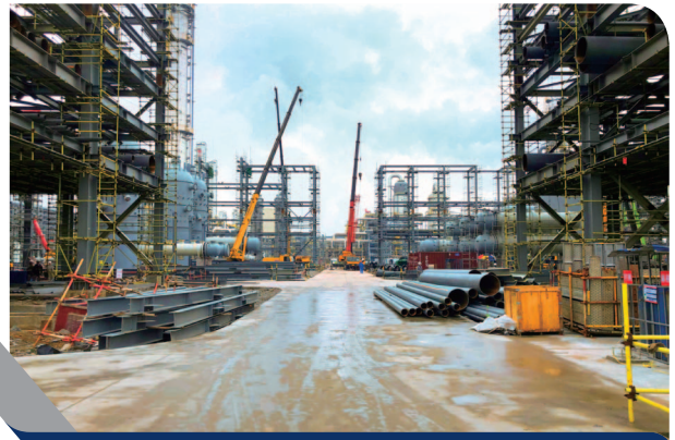
浙江石化乙烯項目獲得質量及施工管理等多項榮譽
