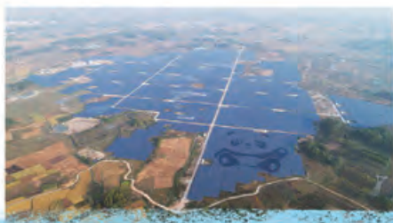
Photovoltaic + Agriculture 光伏+農業
