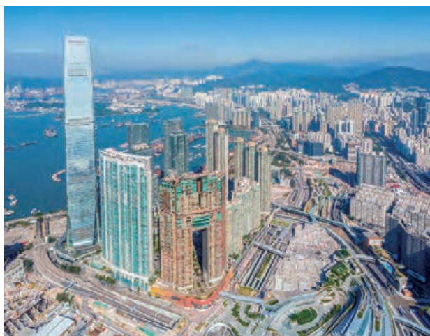
○ 位於高鐵西九龍總站上蓋的大型地盤
