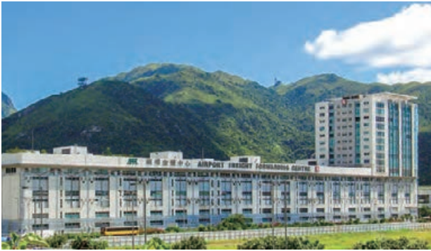
○ 香港機場空運中心
