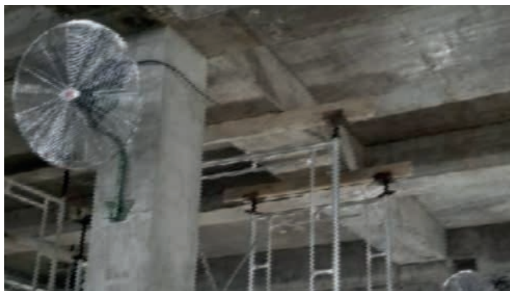
Install fans in dungeon to improve ventilation 在地牢中安裝風扇，以改善通風
