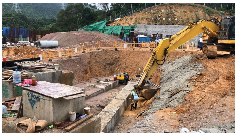
渠務系統建造
