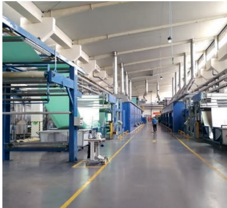
位於越南廣寧省的生產設施，在環境評估中接受檢查。
