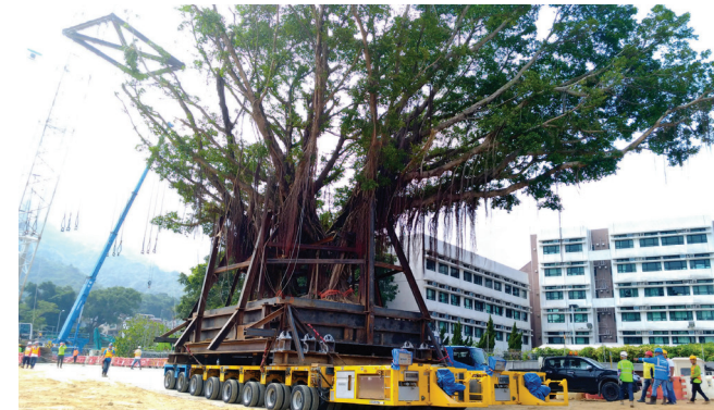
• 西沙路擴闊工程的連理樹保育
