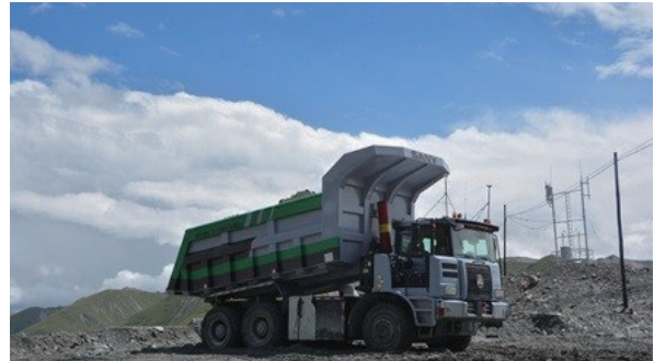
挖机驾驶员通过5G技术远程操控的挖掘机正在矿区采场边坡有序的作业
