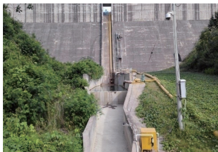
紫金山金铜矿废水外排口及在线监测系统
