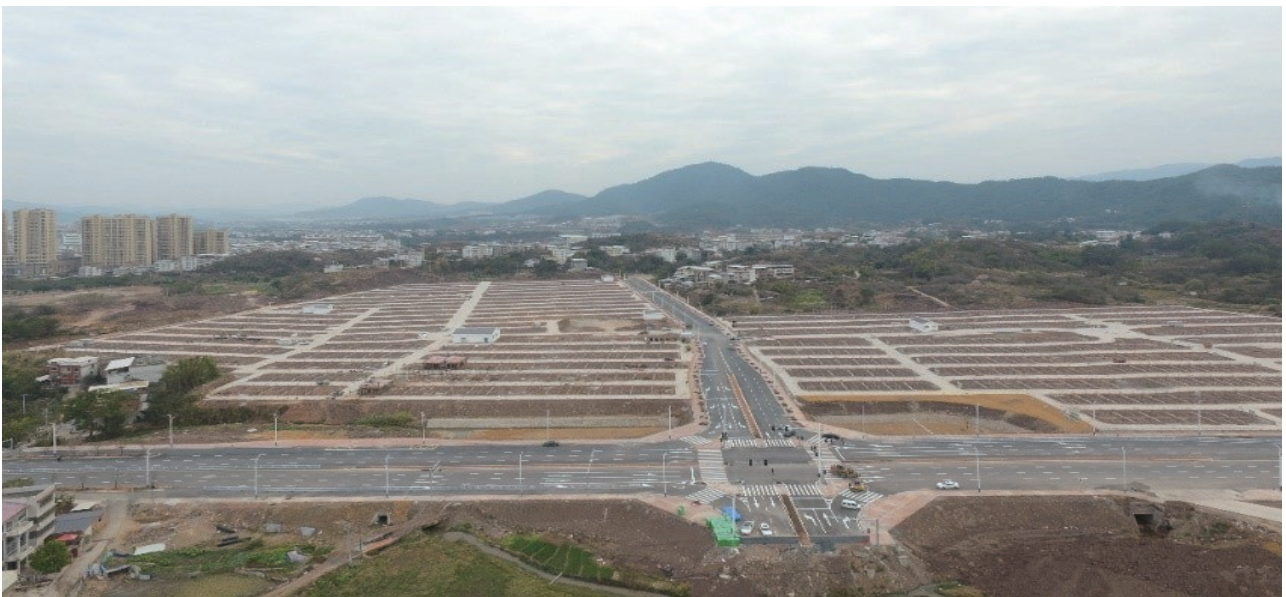
迳美村移民安置地项目实景
