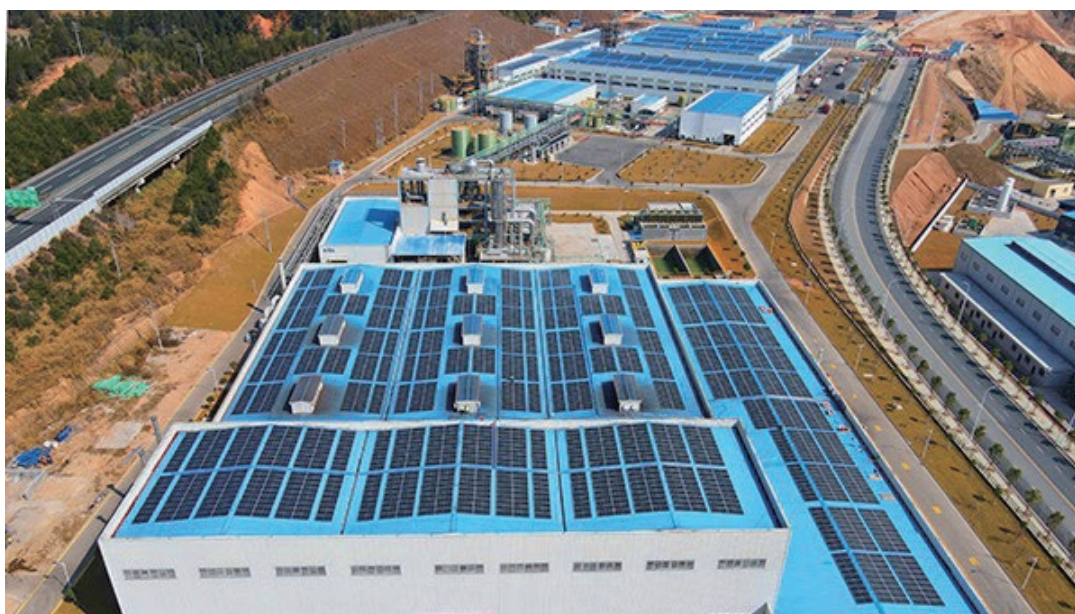
紫金新能源公司建设的首座3.4MW分布式光伏发电项目投入使用
