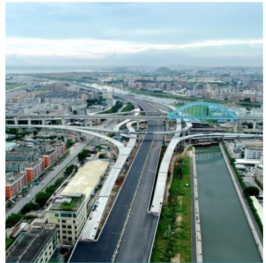
外環高速建設現場
