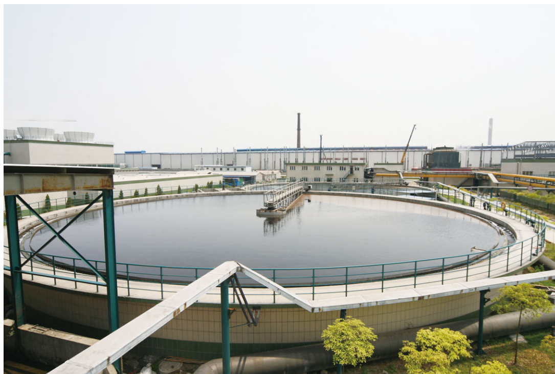
Sewage treatment station 污水處理站
