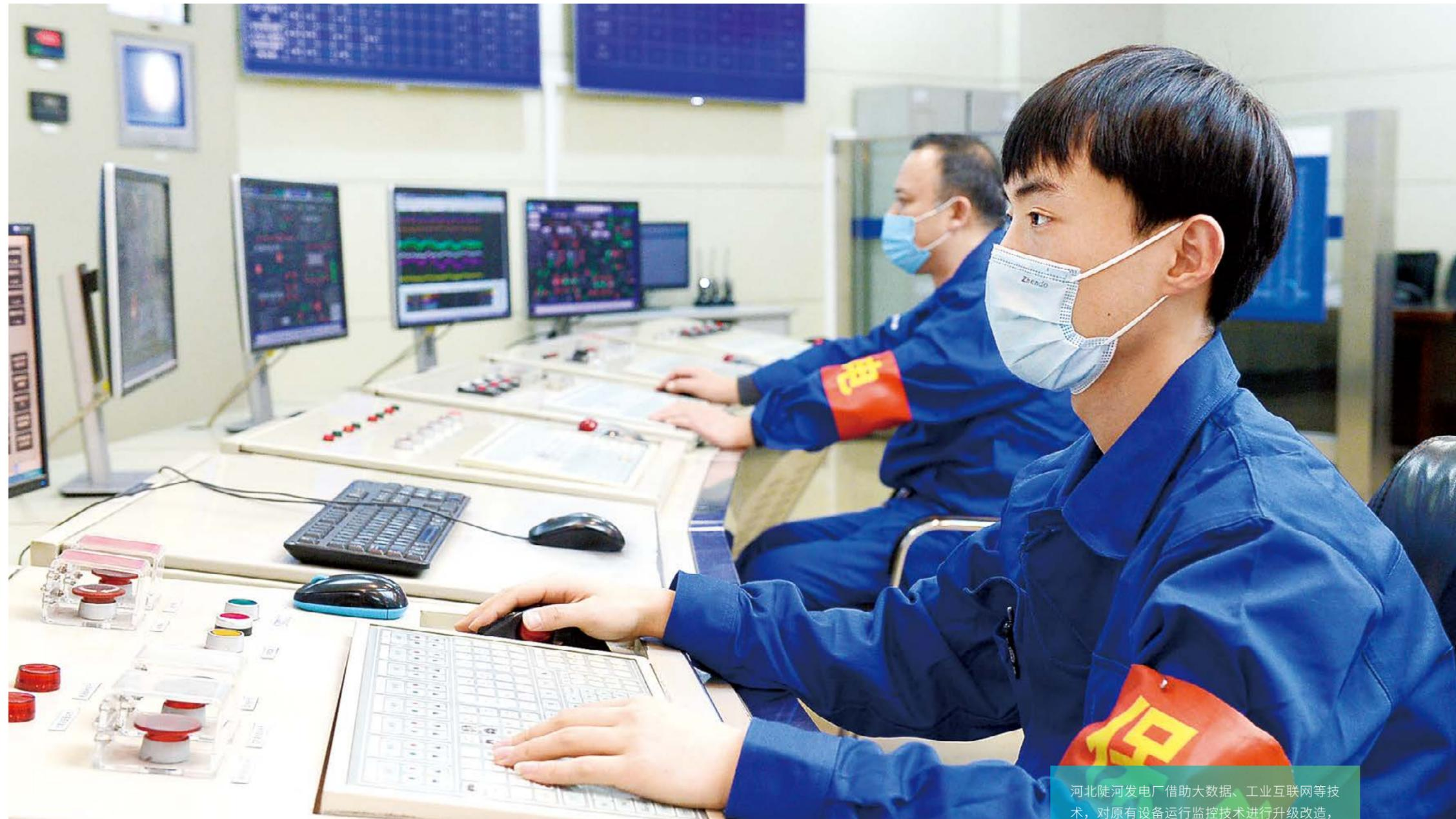
河北陡河发电厂借助大数据、工业互联网等技术，对原有设备运行监控技术进行升级改造，将40余年的运行经验和历史数据转化为数字模型，研发并应用“发电机组辅助预警系统”，实现发电机组运行在线分析与预警。
