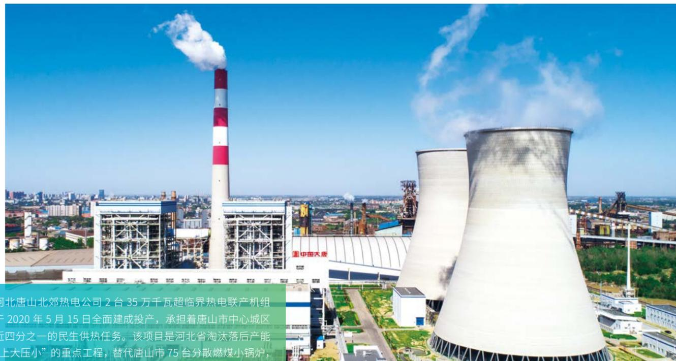
河北唐山北郊热电公司 2 台 35 万千瓦超临界热电联产机组于 2020 年 5 月 15 日全面建成投产，承担着唐山市中心城区近四分之一的民生供热任务。该项目是河北省淘汰落后产能“上大压小”的重点工程，替代唐山市 75 台分散燃煤小锅炉，每年可减少天然煤耗煤量 17.5 万吨、二氧化硫排放 2234.5 吨、氮氧化物排放 1506.7 吨、烟尘排放 1757.9 吨，为改善唐山市大气环境质量发挥重要作用。
