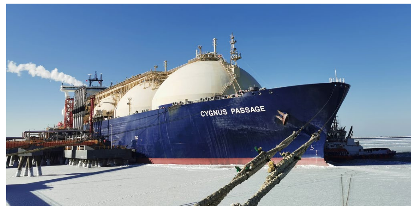
④ 公司天津 LNG 码头进行卸货作业
