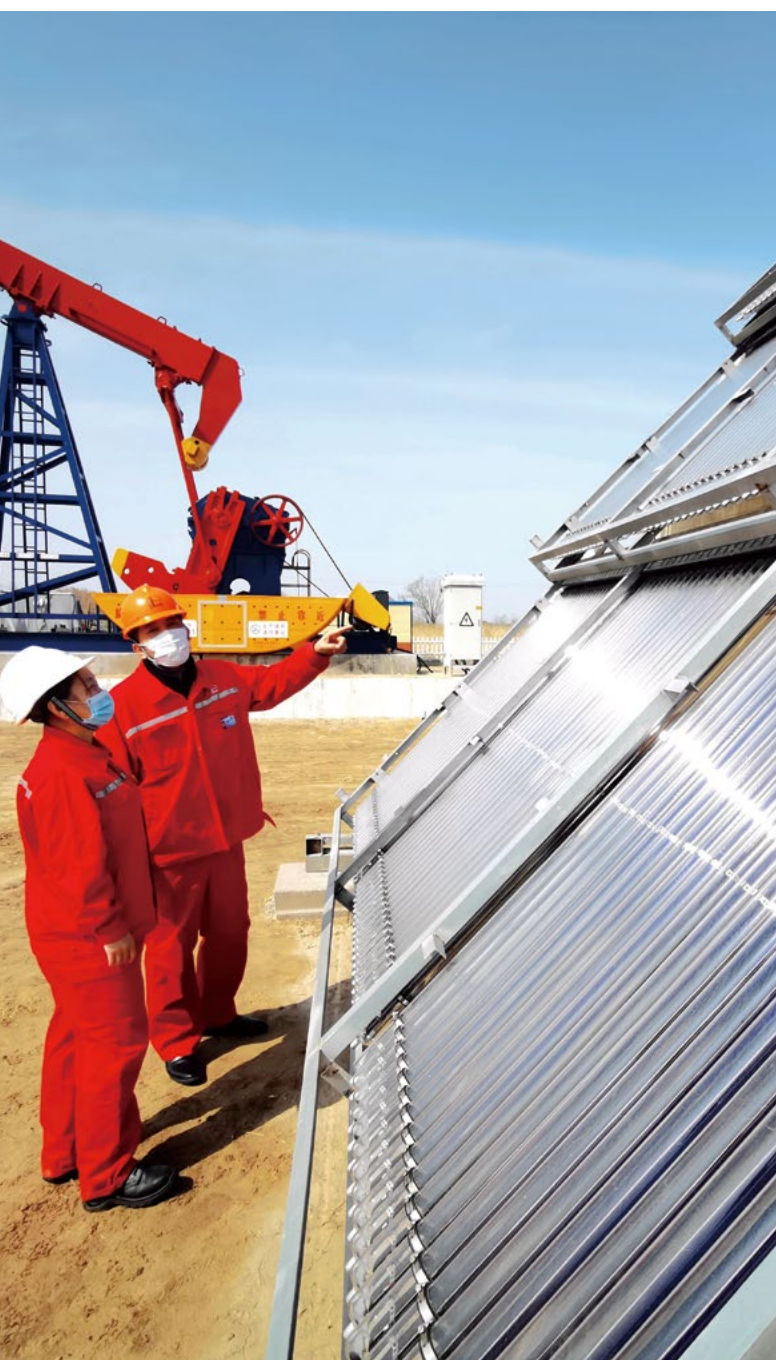
④ 胜利油田孤岛厂应用太阳能自控加热装置助推绿色生产
