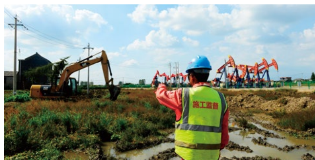
④ 华东石油局泰州采油厂职工在仓西 3-9 平台指挥复垦施工
