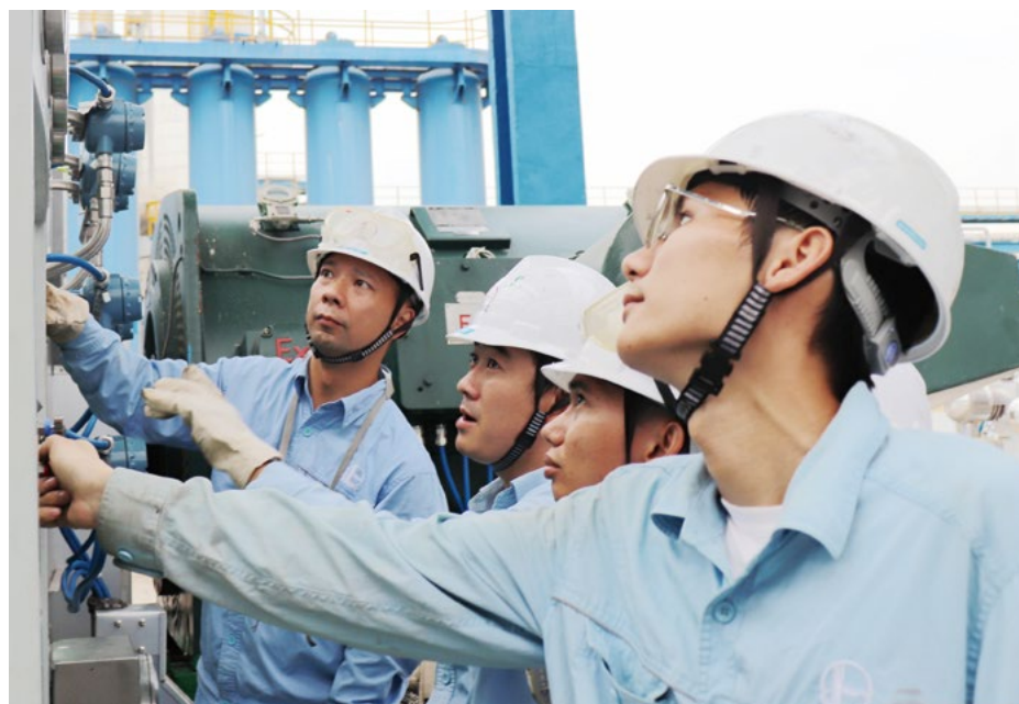
④ 广州石化技术人员对氢气压缩机进行高压试运
