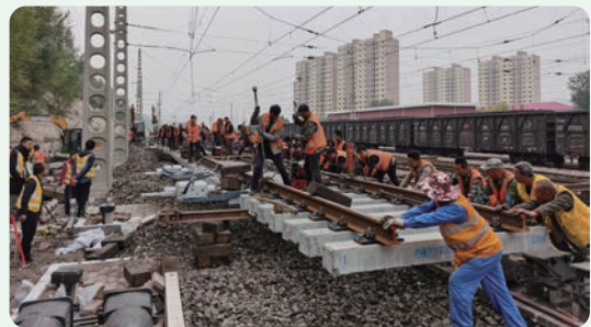
專用線鋪軌作業現場
