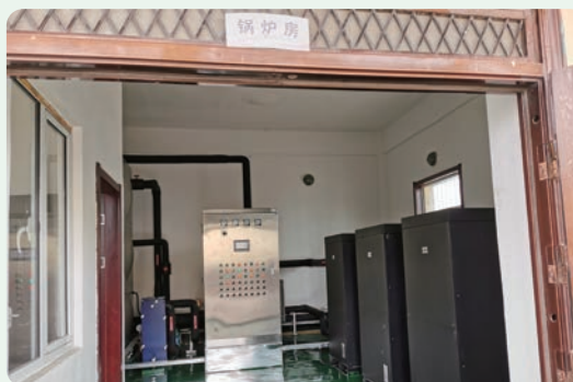
改造後的鍋爐房
