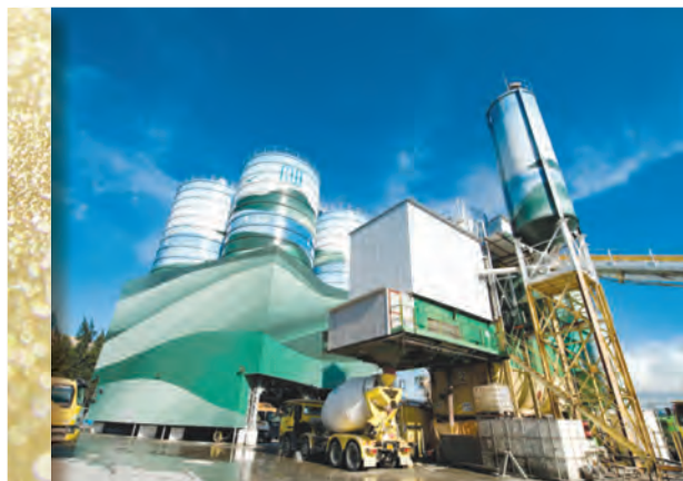
位於香港大埔嘉華混凝土有限公司的生產設施
