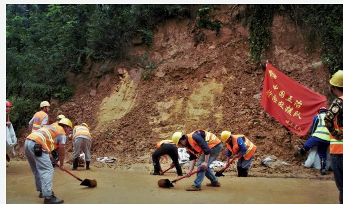
中國五冶處置道路山體滑坡及道路保通
