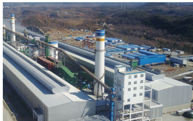
500kA 大型預焙電解槽工程——貴州華仁項目 Guizhou Huaren large-scale pre-baked electrolytic cell project
