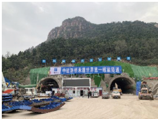
圖註：新晉高速項目施工現場
