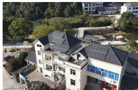
圖：“消薄”席家村屋頂光伏發電項目，預計為村集體增收 16 萬元/年
