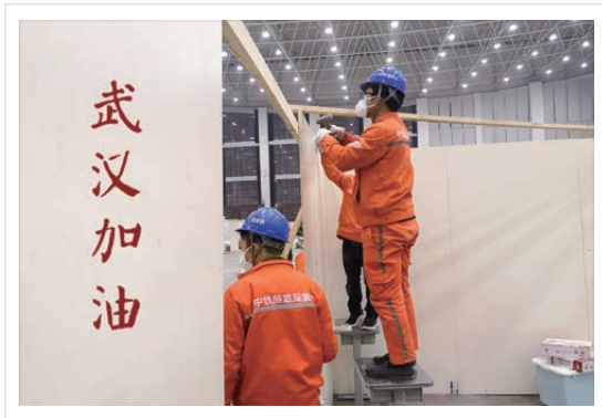
中铁隧道局武汉项目支援武汉客厅方舱医院建设
