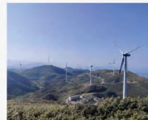
風力發電機群
