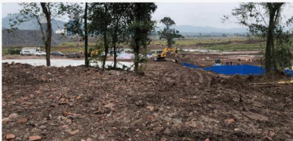
垃圾焚燒發電項目施工現場
