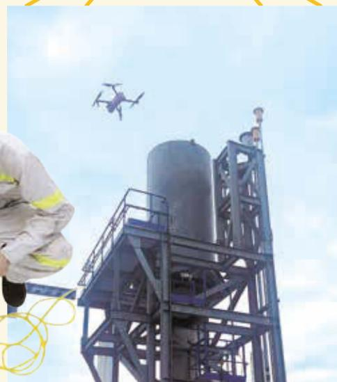
港燈員工採用無人機協助檢驗燃煤發電機組及燃氣聯合循環發電機組的消音器。
