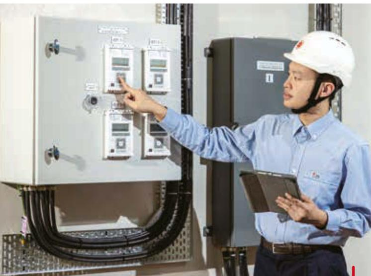
電子接地故障顯示器有助提升網絡的防禦能力。
