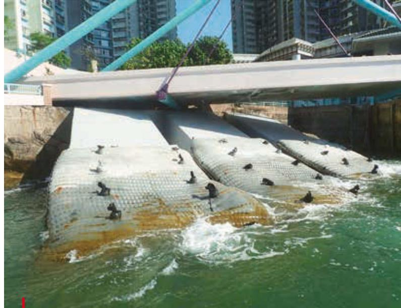
鋪設混凝土墊層和其他有助抵禦極端天氣的保護裝置，加強供電設施的防洪能力。
